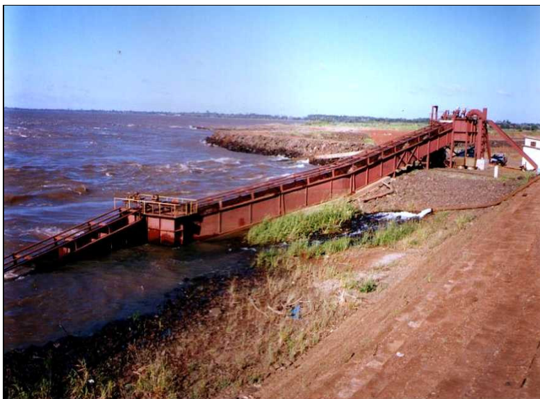
Figura 5 – escada experimental da barragem de Porto Primavera, com sistema de transporte por caminhões. (fonte: Jensen, et al., 2004).
