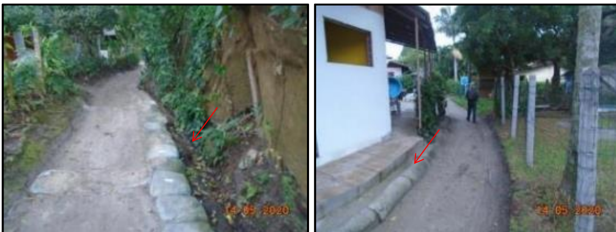
Figura 5 – Trecho de curso hídrico com leito antropizado, atualmente marginal à trilha de acesso (UTM E:769.819, N:7.169.025 e E:769.826, N:7.169.000)
