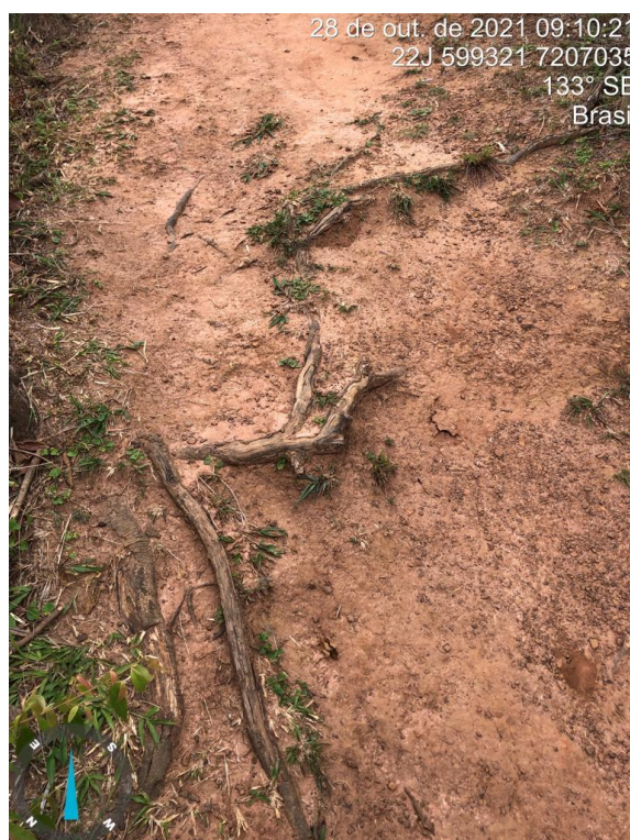
Figura 6 - Erosão laminar na trilha do PEVV.
